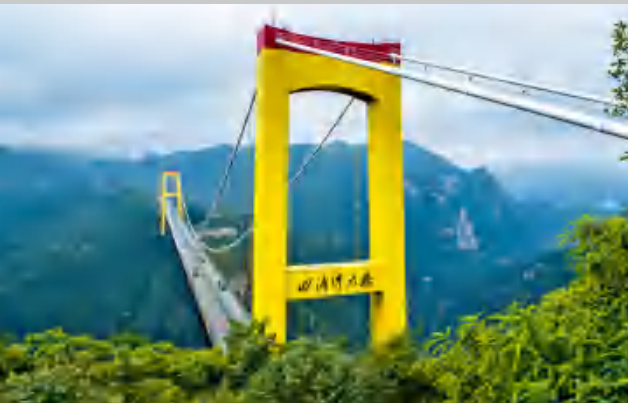
沪蓉西四渡河特大桥
