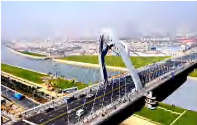
京杭运河常州市区段改线工程
