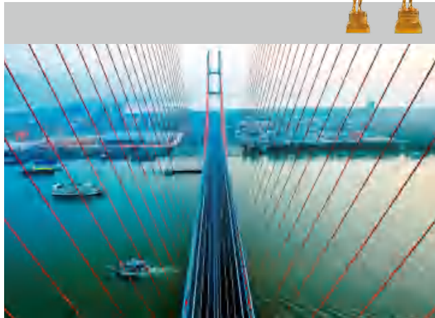
江西九江新长江公路大桥
