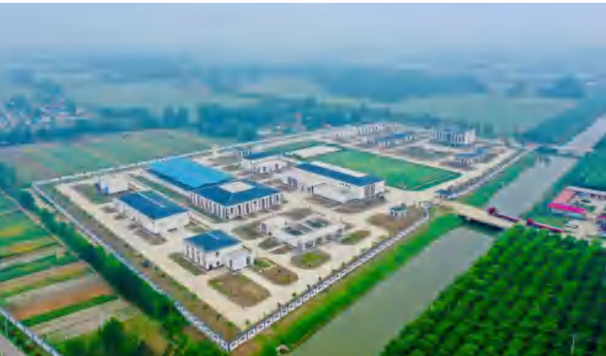
江苏省邳州市第二地面水厂工程
