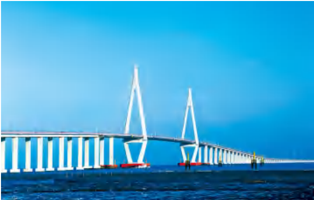
杭州湾跨海大桥
