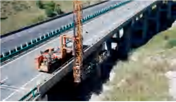
桥梁外观检查
