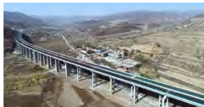
延崇高速交安工程
