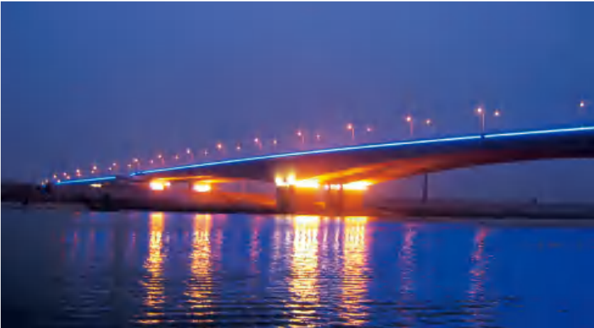
广东佛山季华大桥 佛山季华大桥全长 951 米，主桥 415 米，为三跨连续刚构桥，2005 年 12 月建成。
