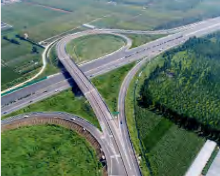
济青高速改扩建工程 济南至青岛高速公路改扩建工程全长 309.2 公里，总投资 297.96 亿元，是国内一次性改扩建里程最长、投资最大的高速公路工程，第一个高速公路改扩建绿色科技示范工程和山东省新旧动能转换重点项目，2019 年 7 月建成。
