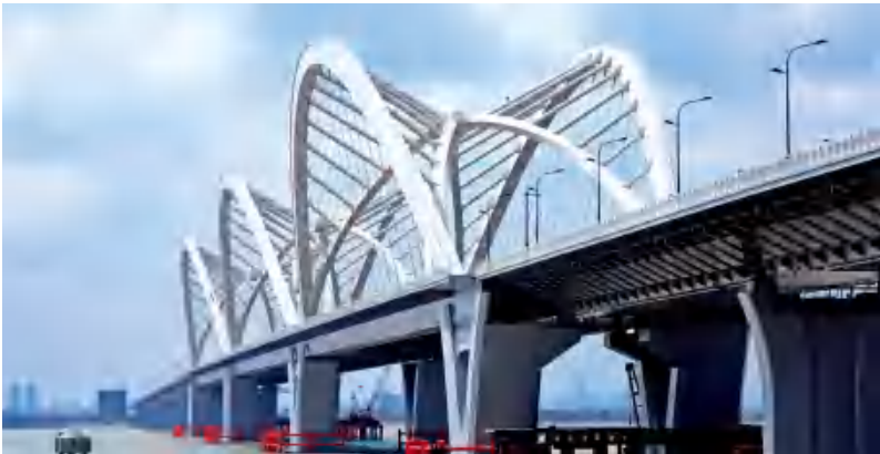
浙江杭州九堡大桥
