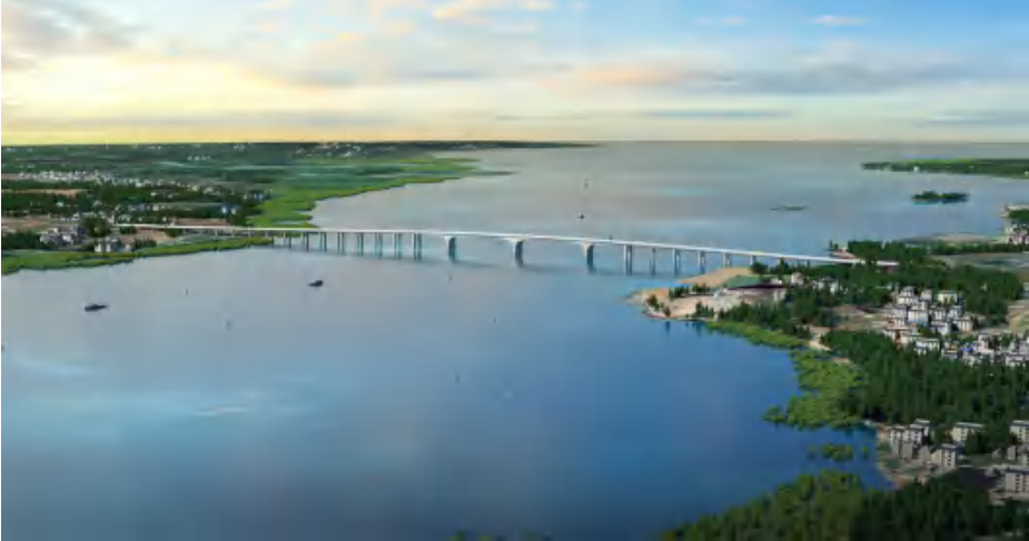
广西大风江大桥 大风江大桥工程全长约 5 公里，其控制性工程大风江大桥全长 1544.5 米，其中主桥为（85+2×160+85）米预应力混凝土连续梁桥，引桥长 1054.5 米。
