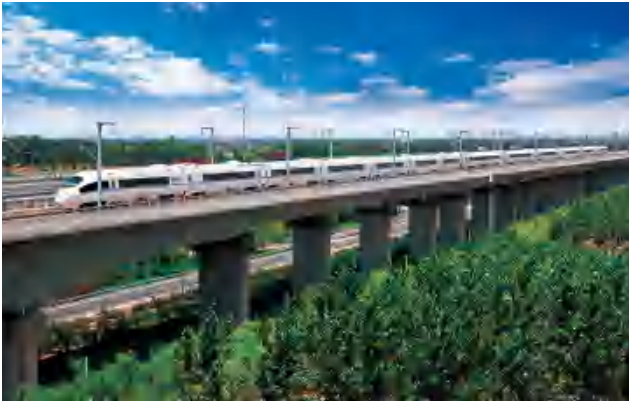
京沪高速铁路丹昆特大桥阳澄湖桥段
