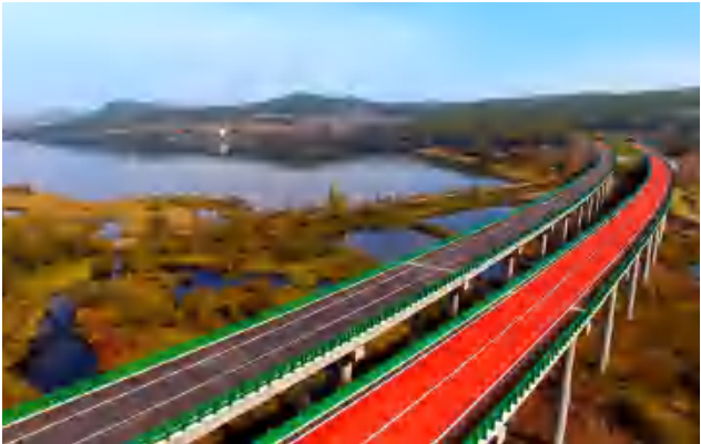
鹤大高速公路小沟岭至抚松（小沟岭至大蒲柴河段）
