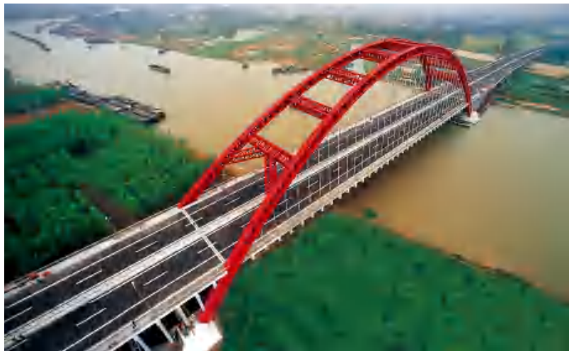
江苏连徐高速公路京杭运河特大桥
