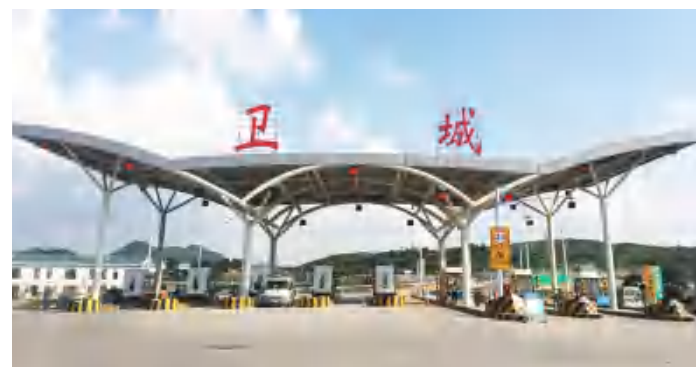
贵州贵黔高速公路 - 卫城收费大棚
