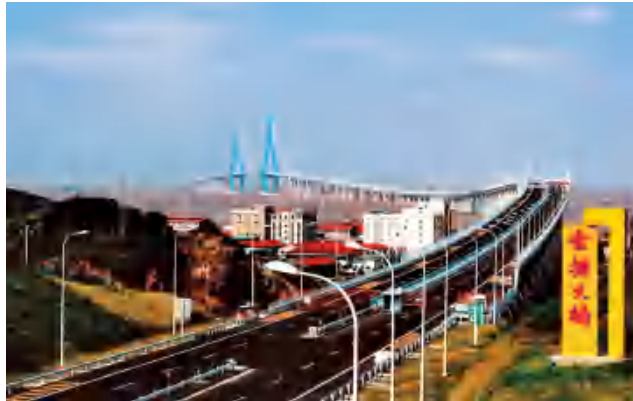
浙江舟山大陆连岛工程金塘大桥项目
