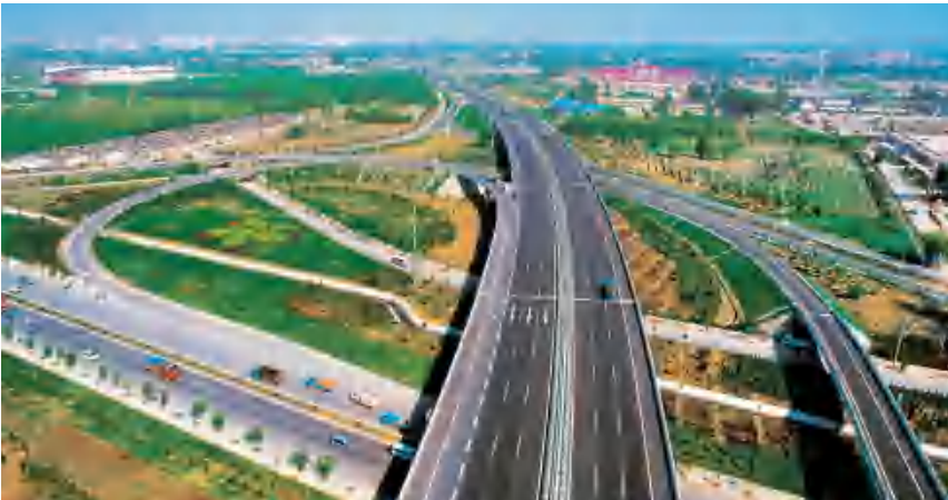
北京五环路姚家园立交桥 姚家园立交桥，主线桥全长 538.04 米，上部结构为预应力砼连续箱梁，2002 年 10 月建成，荣获“2002 年度北京市政基础设施竣工长城杯金质奖工程”。
