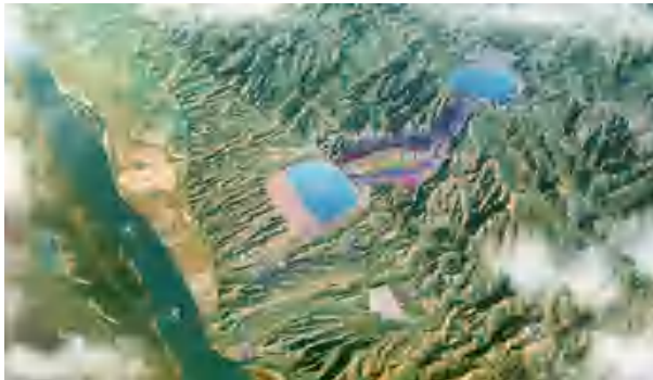
宁夏牛首山抽水蓄能电站项目
