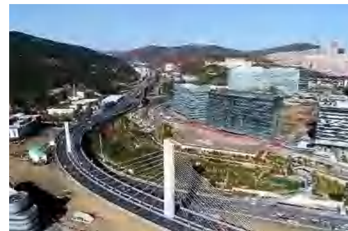
大连南部滨海大道西延伸线工程
