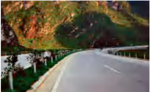
广西河池（水任）至南宁高速公路 水南高速公路全长 236.76 公里，沿线山岭起伏，有典型的喀斯特岩溶地形，有膨胀土、湿地、软基，堪称广西地质的“标本集”，2004 年 9 月建成，荣获“2005 年度广西优质工程”。
