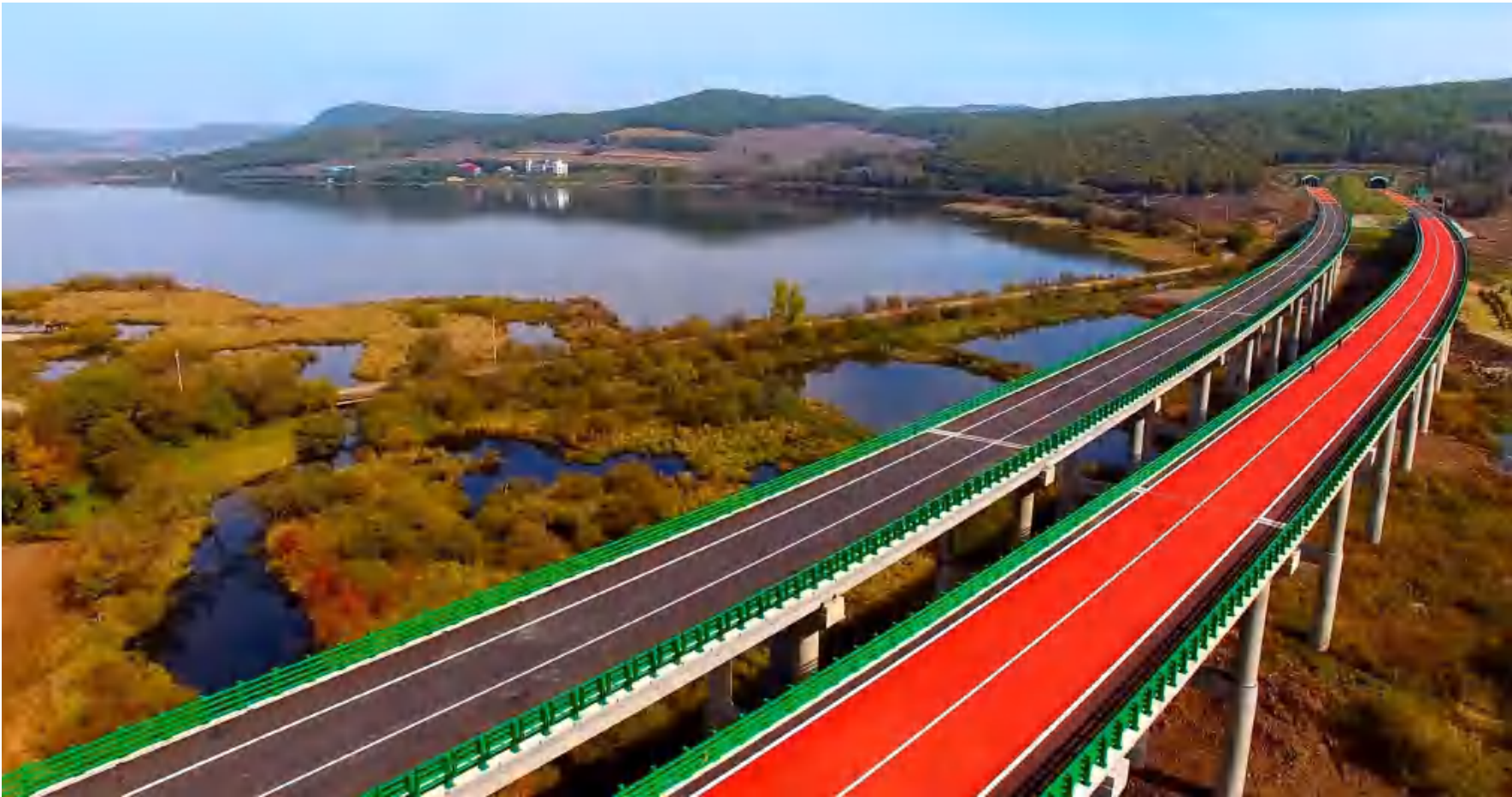
吉林鹤大高速 鹤大高速公路小沟岭至大蒲柴河段位于吉林省东部山区、长白山腹地，沿线生态环境敏感、抗冻耐久性要求高，2016 年 10 月建成。该项目作为交通运输部“资源节约循环利用科技示范工程”和“绿色循环低碳公路主题性项目”，成为我国公路交通建设领域首个季冻区新建公路“双示范”工程，荣获“中国建设工程鲁班奖”。
