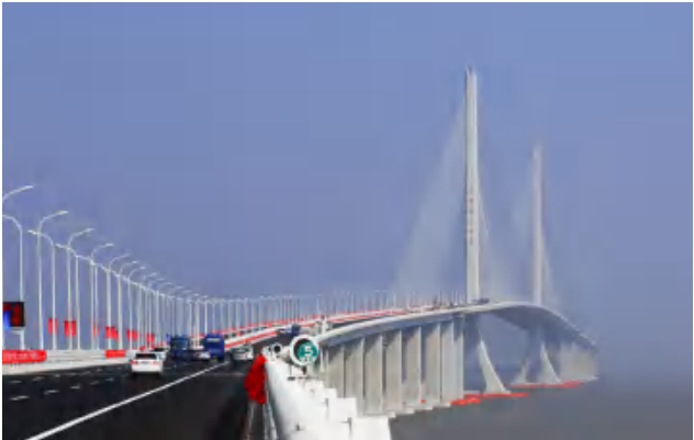
上海崇明越江通道（长江隧桥）
