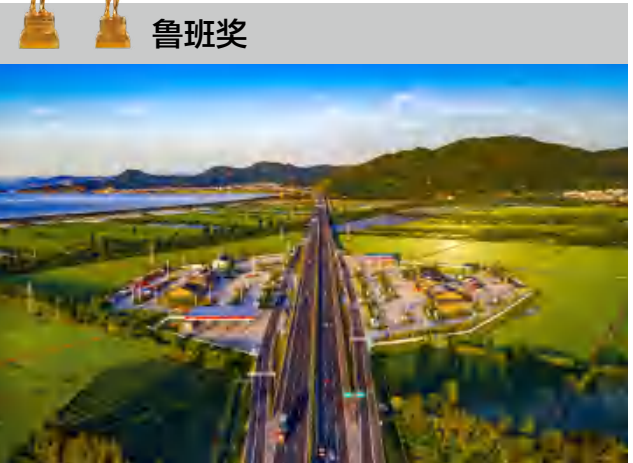
浙江台州湾大桥及接线工程
