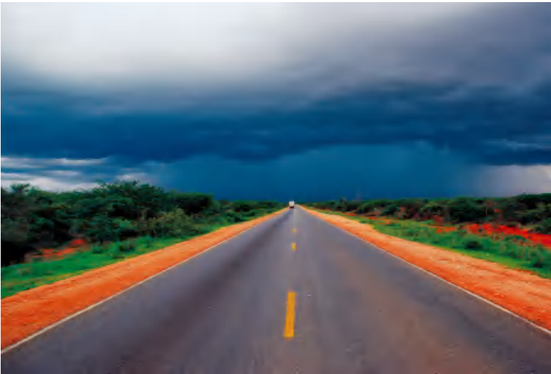
坦桑尼亚 FD 项目公路工程
