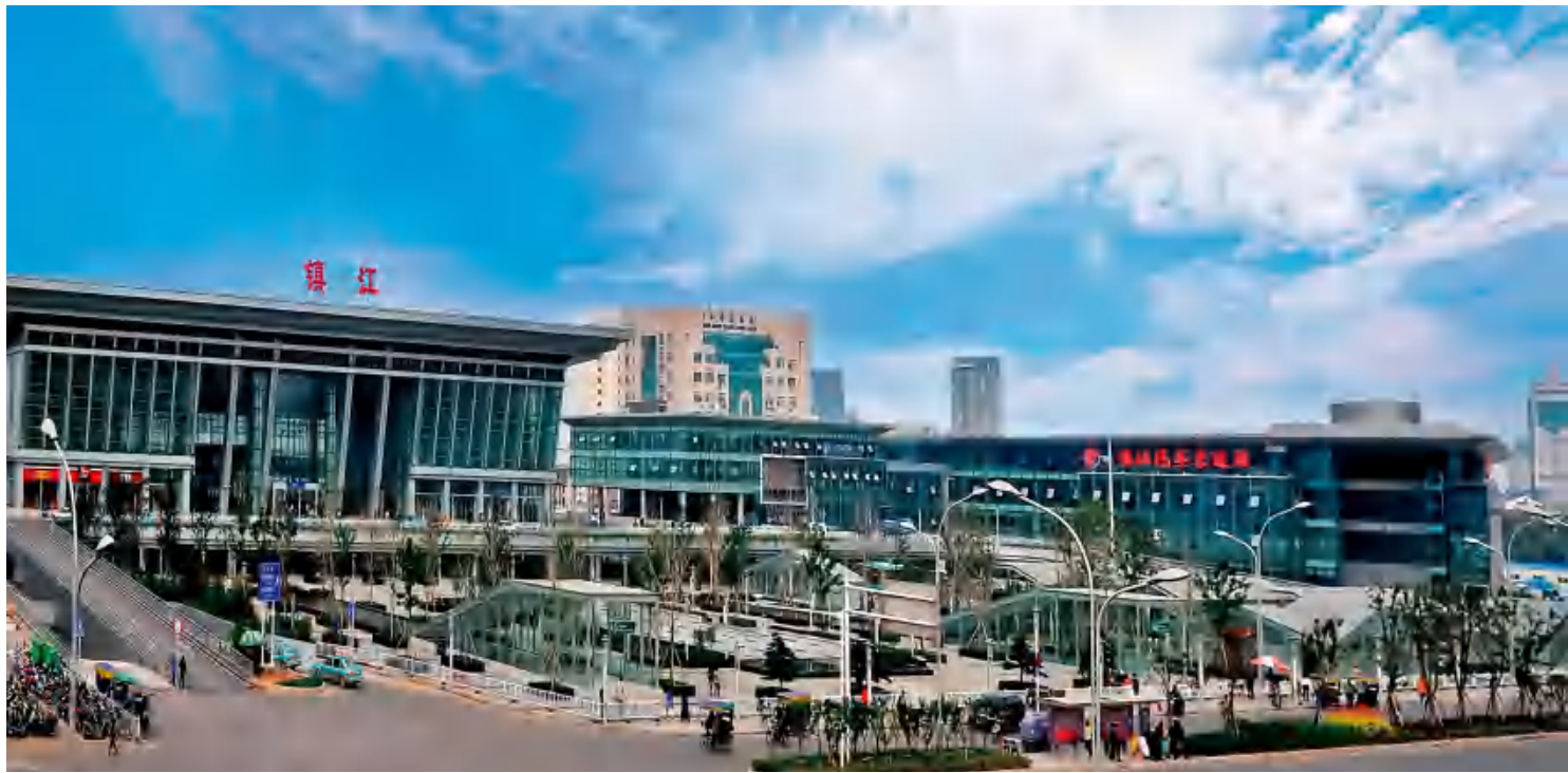
沪宁城际铁路镇江站市政配套工程
