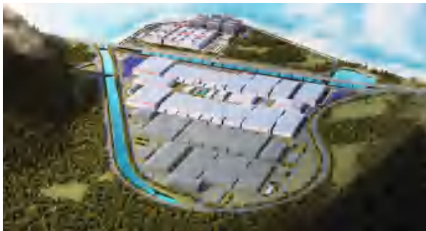
福建宁德锂电车里湾园区及配套基础设施项目
