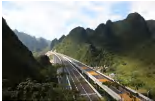
广西河池至都安高速公路 广西河池至都安高速公路地处桂北大石山区，全长 93.8 公里，是广西高速公路网规划和西部大开发省际公路通道的重要组成部分，荣获“国家优质工程金奖”“李春奖”。
