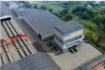
水泥混凝土搅拌站
