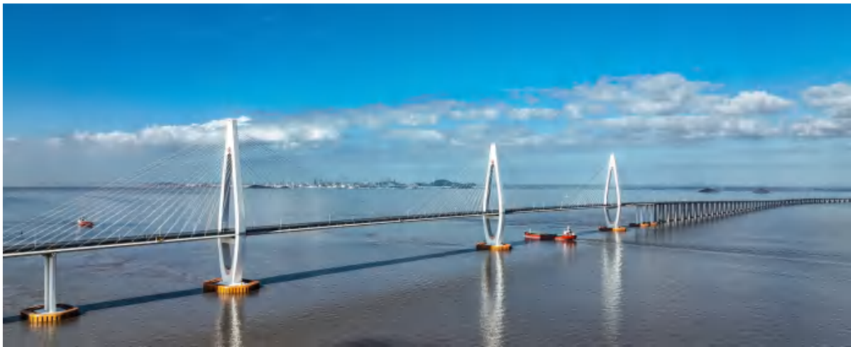
浙江舟岱跨海大桥
