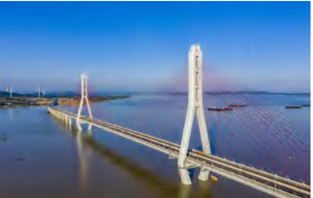
江西都昌至九江高速公路鄱阳湖二桥
