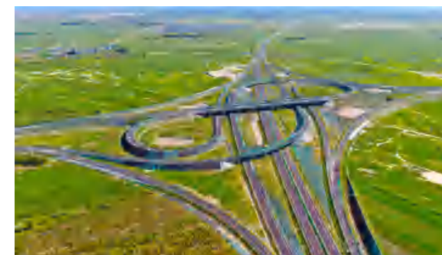
吉林松通 GQ09 工区项目
