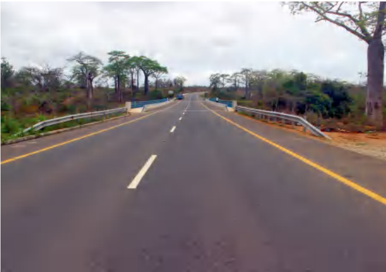
安哥拉 CAXITON' ZETO 公路改扩建项目
