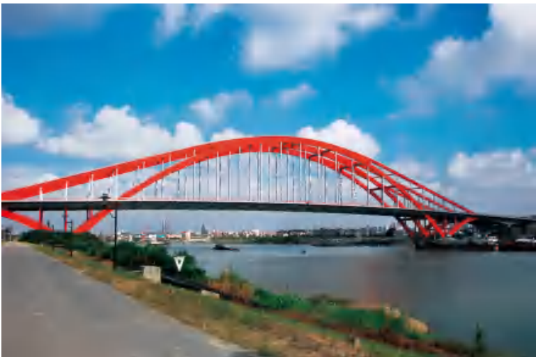
广东佛山东平大桥
