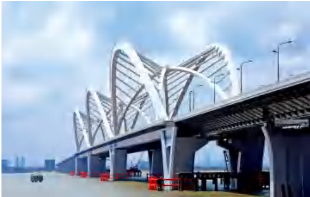
浙江杭州九堡大桥
