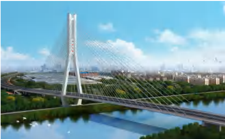
广东南庄大道东延工程（凤翔大桥） 凤翔大桥为主跨 268 米的独塔斜拉桥，桥长约 1100 米。建成后将成为佛山市内最大的独塔斜拉桥。
