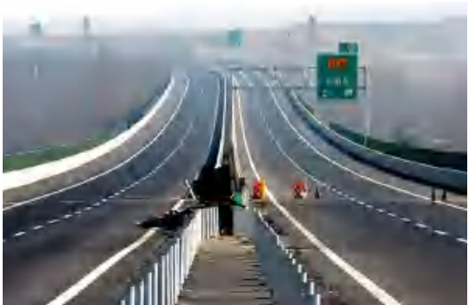
吐鲁番－和田联络线 G3012 墨玉至和田段高速公路 墨玉至和田段高速公路，全长约 74 公里，2018 年 8 月建成。
