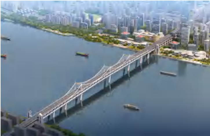
浙江温州永宁大桥 永宁大桥是温州市域铁路 S3 线一期工程与温瑞大道南段快速路跨飞云江公铁共建桥梁，北起飞云江北岸瑞光大道，南至飞云江南岸纬五路附近，长约 3.1 公里，其中跨江范围长约 1.1 公里。
