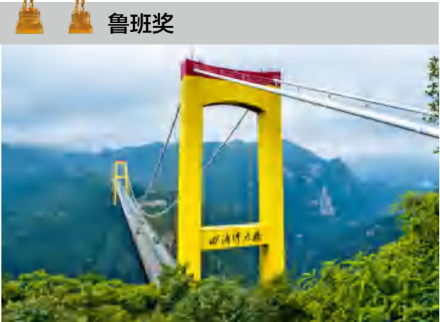
湖北沪蓉西高速公路四渡河特大桥
