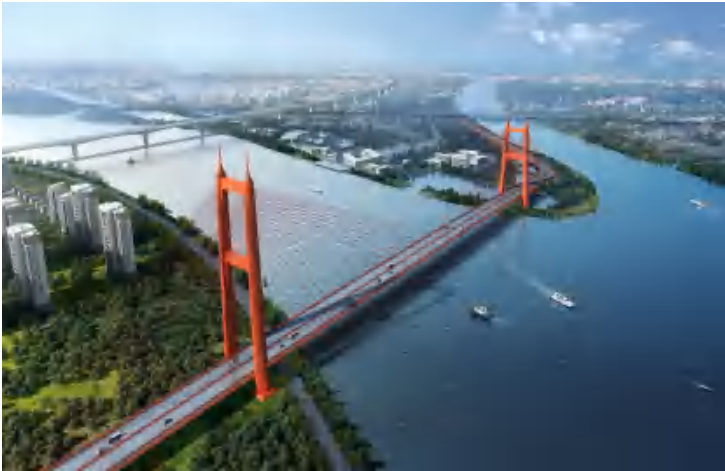
广东佛山南国路东延线顺德大桥 佛山市顺德区南国东路延伸线工程位于顺德区东部新城，路线全长 2.7 公里，其控制性工程顺德大桥全长 2222.5 米，横跨容桂水道，主桥为跨径 626 米的高低塔混合梁斜拉桥。
